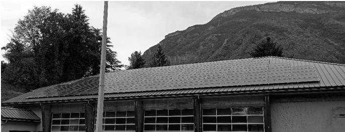
**Photo 5.19. Même toiture avec suppression des édicules, après les travaux photovoltaïques** (source : Cythelia Energy)
