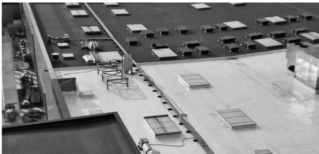
**Photo 6.3. Limite entre bitume et membrane synthétique**
